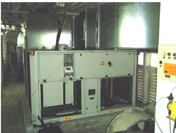
該名員工在水泵機組進行更換工作
